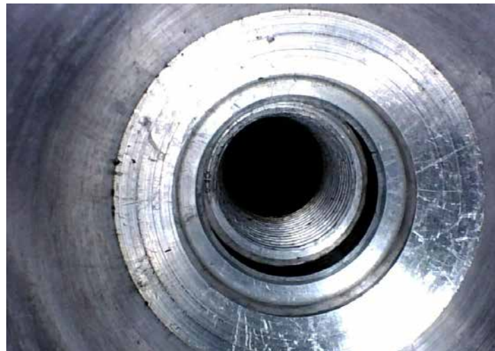
Foto boven: Inspectie van een bougiepoort
